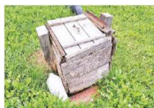
Ликвидирован колодец в аварийном состоянии по ул. 40 лет Победы в д. Пелевиной.
